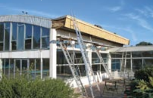
Toiture de la piscine
